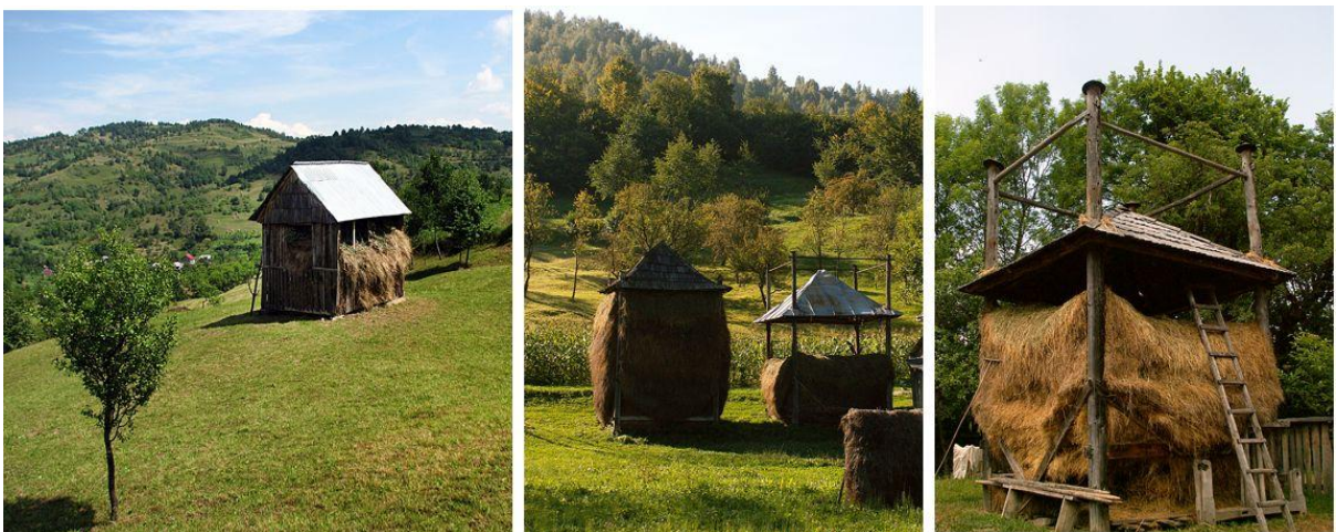
Imag. 24: Șoproane de fân amplasate pe fânețe. Stânga: șopron cu acoperiș fix (Botiza, jud. Maramureș, 2014, foto B. Iancu). Centru și dreapta: șopron cu acoperiș mobil (Strâmtura și Budești (MM), 2009, foto A. Iuga).
