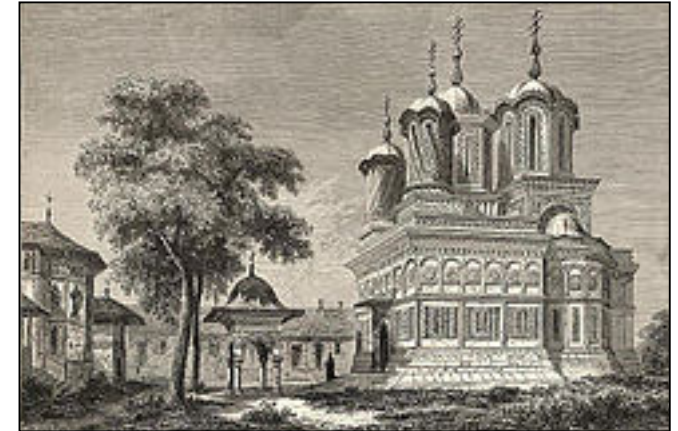
1. Aspectul inițial al mănăstirii, înaintea restaurării din 1875-1886.
