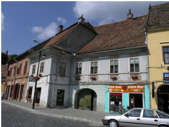
Place Hermann Oberth no. 13: ont été repeinte seulement les deux travées au rez-de-chaussée, qui correspondent a un espace commercial.
