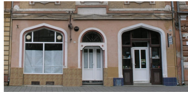
Place Hermann Oberth no. 32: remplacement des châssis historiques par châssis en PVC blanc
