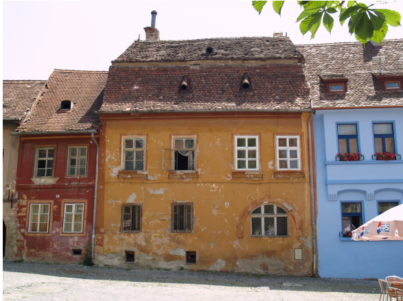
Rue de la Tour no. 3: les six fenêtres à l'étage sont abordées deux par deux, de trois manières différentes: châssis traditionnels en bois avec volets roulants, châssis traditionnels en bois sans volets et châssis / volets en PVC.
