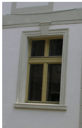
Nouveaux châssis en formes traditionnelles
