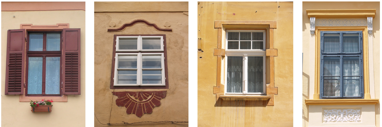
Fenêtres historiques réhabilitées
