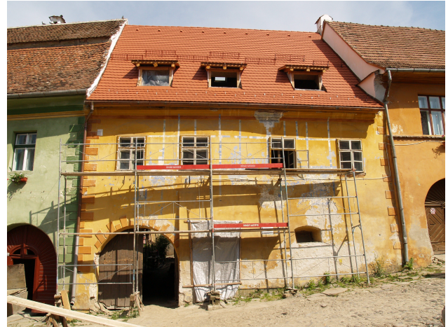
Rue de l'Ecole no. 13
