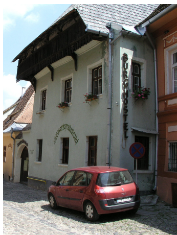
Rue du Bastion no. 4-6, présent “Burg Hostel”, avant et après les interventions
