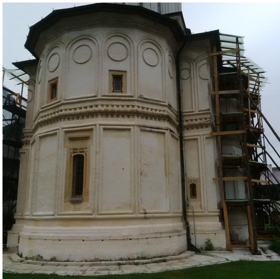
Biserica Sf. Constantin și Elena, în timpul lucrărilor de restaurarea fațadelor
