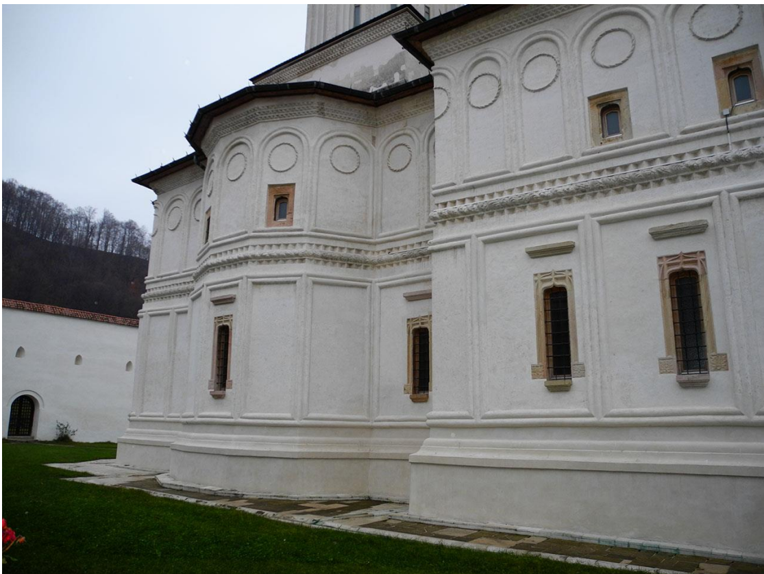
Biserica Sf. Constantin și Elena, după restaurarea fațadelor Fațada de nord
