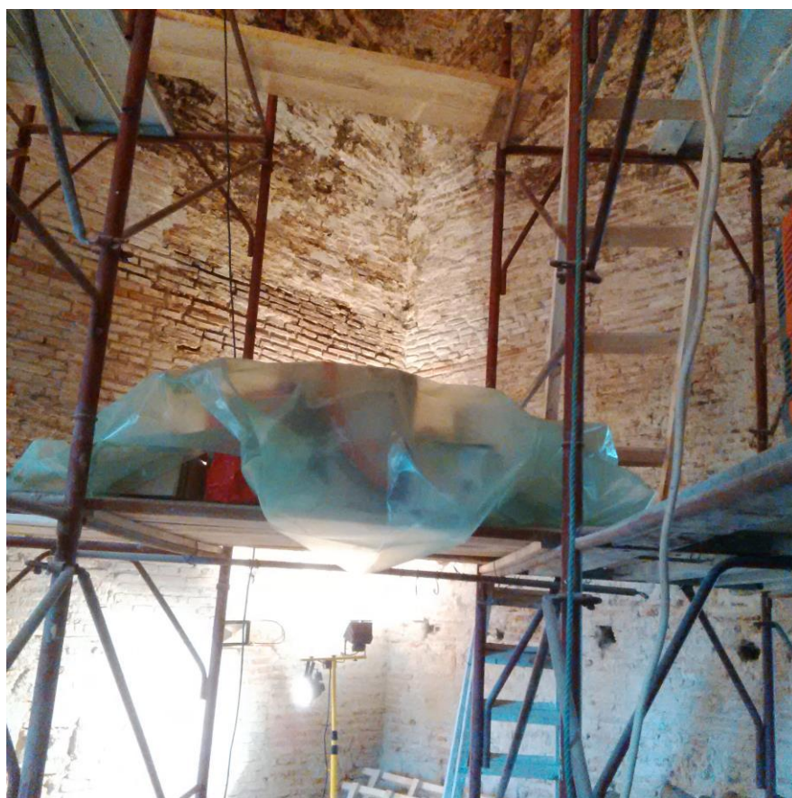
Brutăria din incinta bisericii mari (Incinta sacră), în timpul lucrărilor de restaurare
